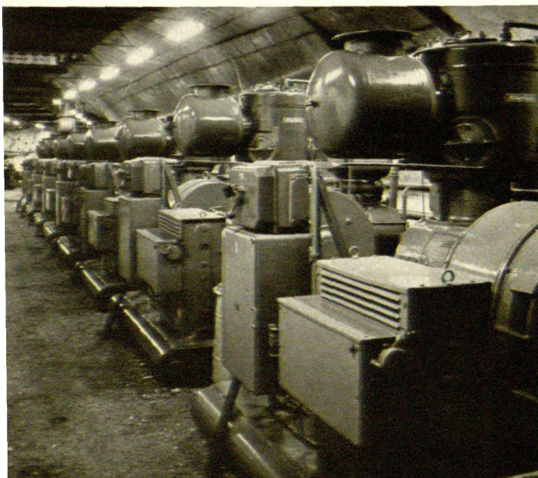
I årets leveranser från Tryckluft AB Atlas Copco ingå bl. a. 12 stationära kompressorer typ AR4E till en ny kompressorcentral för gruvanläggningarna i Kuirunavaara.
