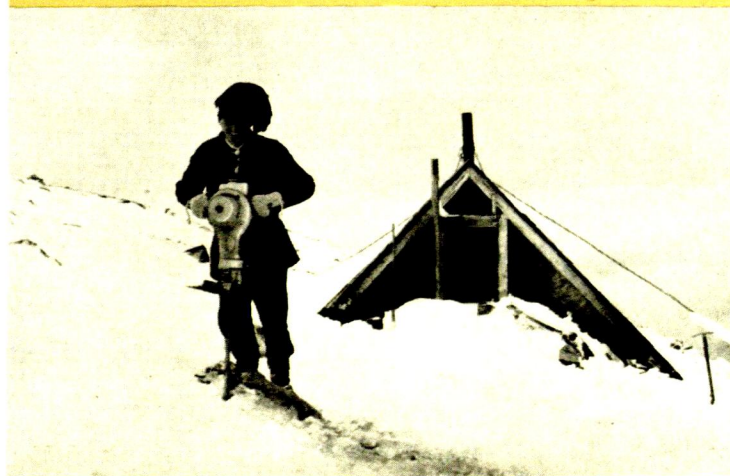
Under sommaren 1956 företogs med gott resultat provborrningar med den nya motorborrmaskinen Cobra i de svenska och norska fjällen samt i Alperna. Bilden visar maskinen i arbete vid toppstugan på Kebnekajse.
