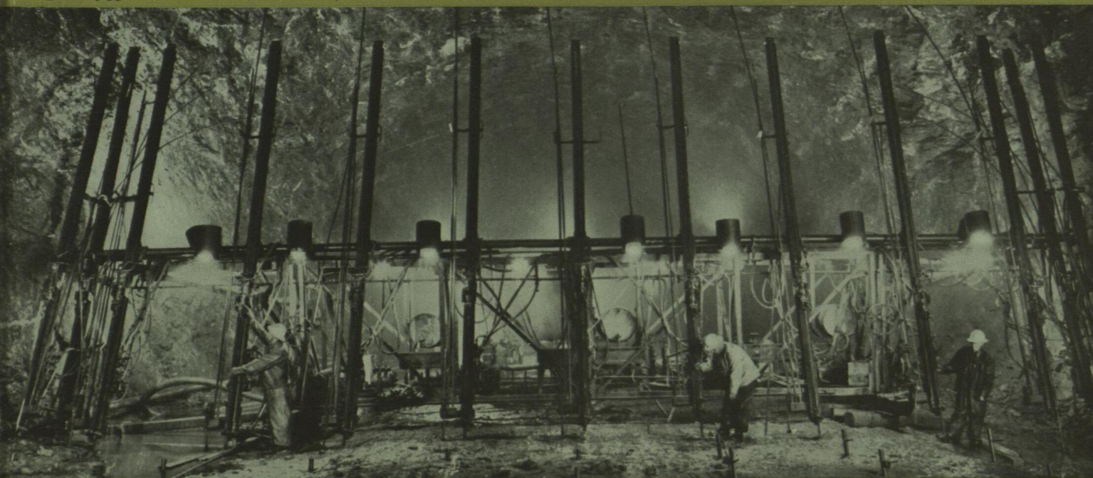
Vid utsprängningen av världens största tunnel i Stornorrfors borrades 150 m per man och skift med Atlas Copcos kedjematade bergbormaskiner.
