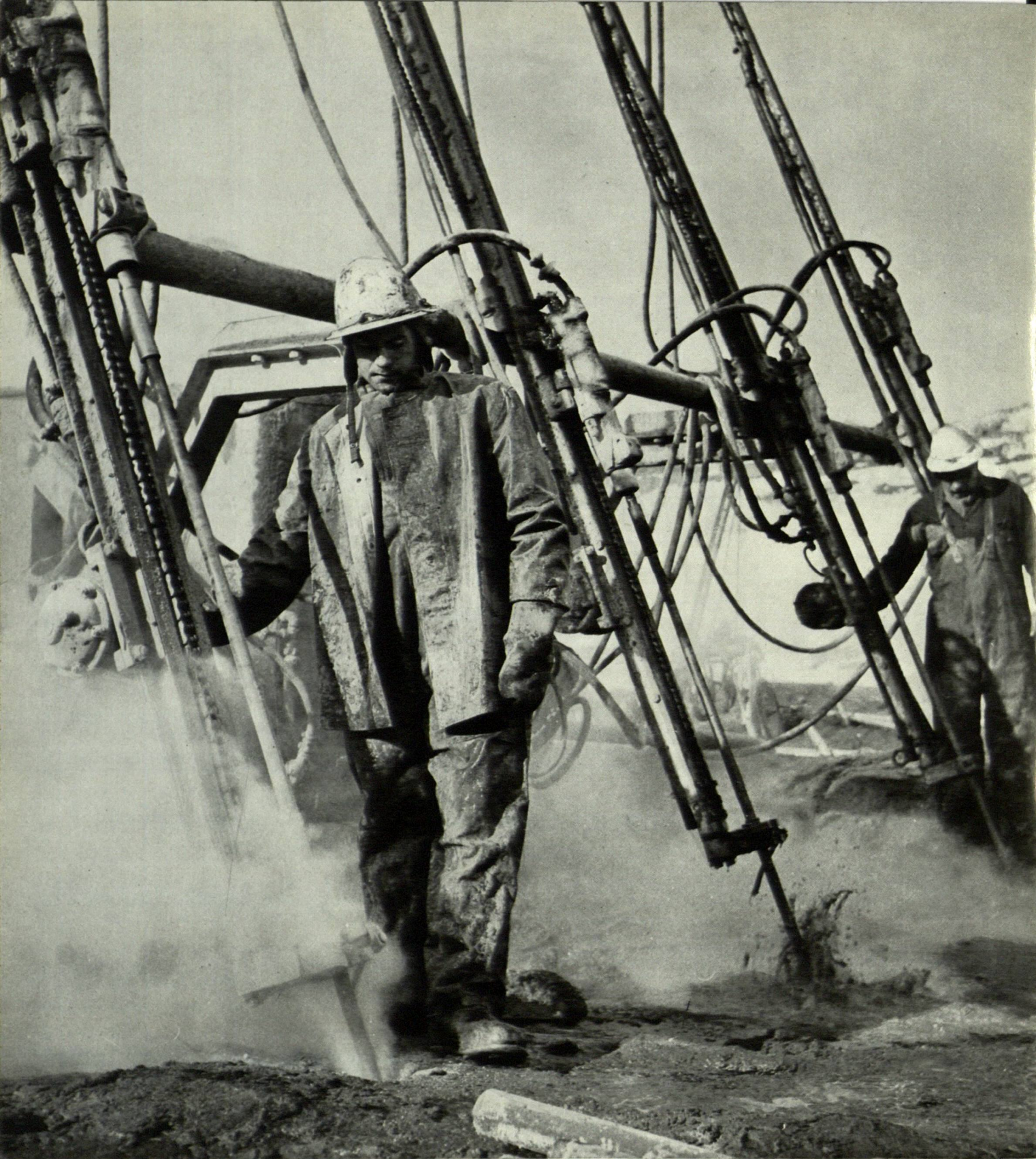
Pallborrning i Stornorrfors, där Sveriges största vattenkraftverk delvis togs i bruk under 1958.
