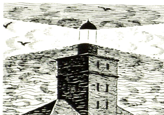
I fyrtornet Mouille Point vid Kapstaden har tryckluftdrivna mistlurar installerats för att varna sjöfarande vid dålig sikt. Kompressorutrustningen är av Atlas Copcos tillverkning.
