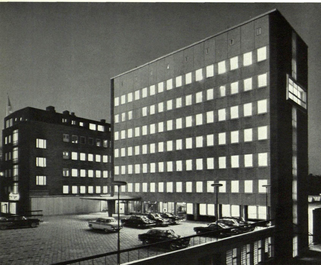
Utbyggnad av verkstads- kontor och huvudkontor i Nacka har slutförts under året. Bilden visar huvud- kontoret med den nya huvudentrén.
