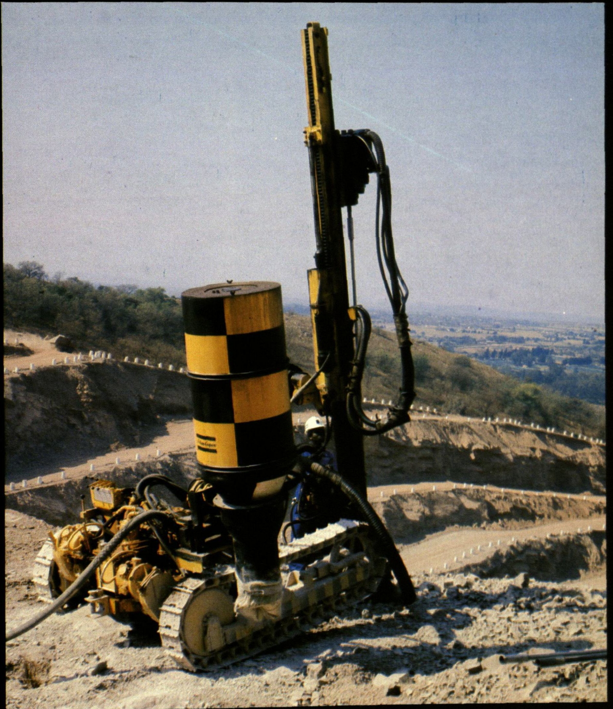
Atlas Copcos satsning på miljöförbättrande åtgärder har nu vunnit internationellt erkännande. Ett exempel är dammavskiljaren DCT, som idag levereras över hela världen. Här ses en DCT monterad på borraragregatet ROC 601 i arbete vid ett stenbrott i Pretoria, Sydafrika.
