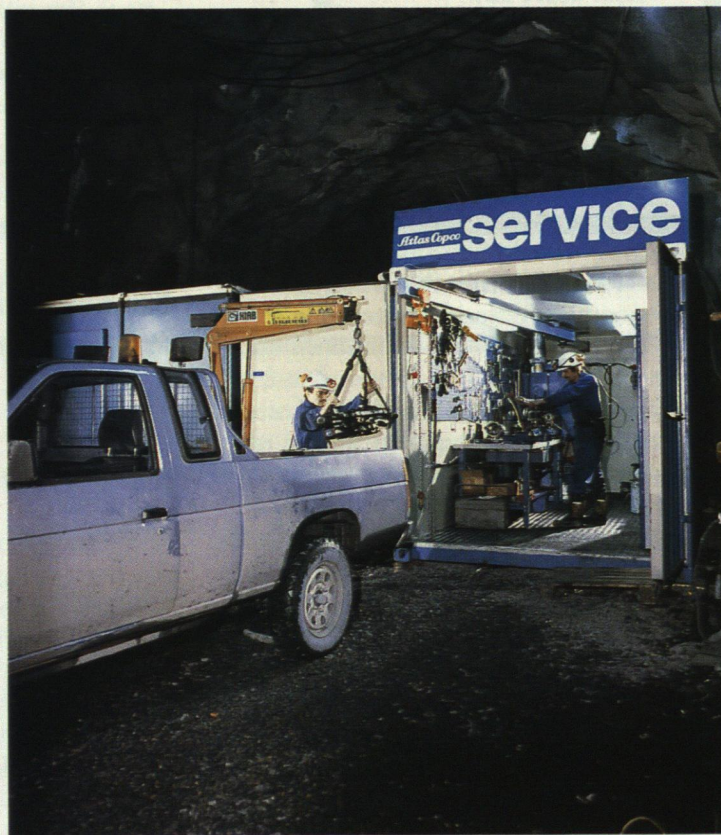
En Atlas Copco servicecontainer installerad vid ett tunnelbygge.
