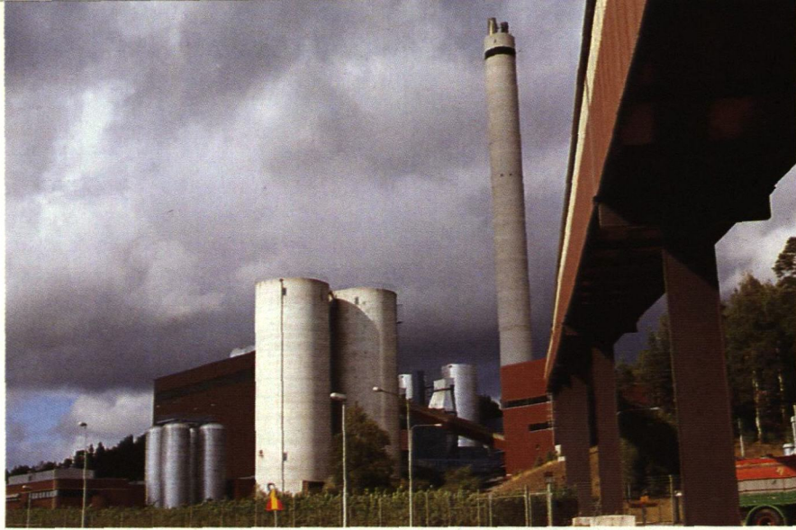
Igelsta värmekraftverk, Södertälje.
