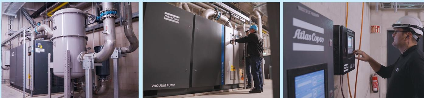
O controlador central ES16 da Atlas Copco pode monitorar e controlar várias bombas de vácuo GHS VSD+ simultaneamente. O sistema de controle inteligente equilibra e otimiza o desempenho de todas as máquinas, reduzindo o consumo geral de energia.
